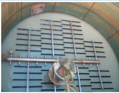
Installazione di diffusori tubolari. Installation of tube diffusers.
