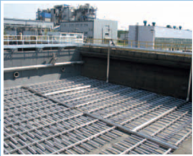
Installazione di diffusori tubolari. Installation of tube diffusers.
